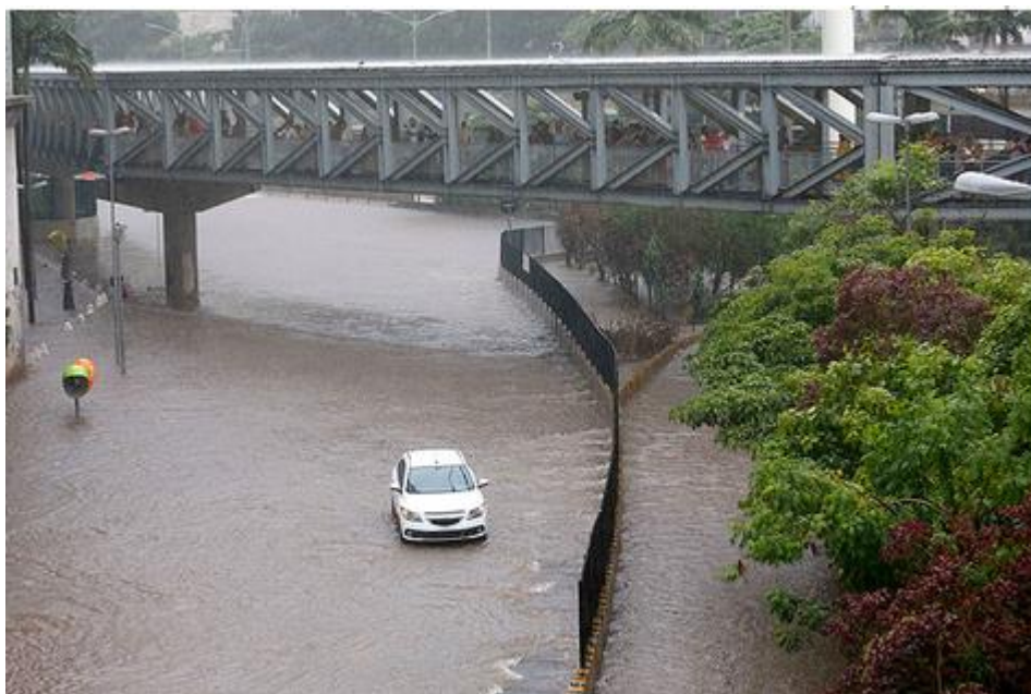
Figura 4. Ponto de alagamento na avenida 9 de Julho, próximo ao terminal Bandeira
